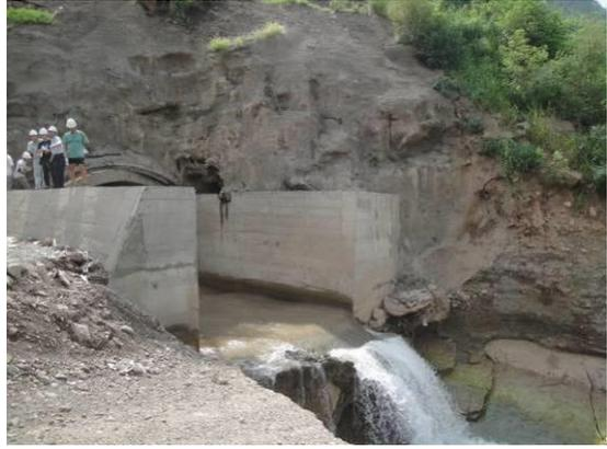
图 5.1.4-7 矮子沟弃渣场排水洞出口
