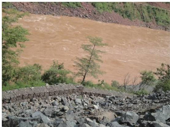
图 5.1.4-8 矮子沟弃渣场沿江钢筋石笼拦挡防护措施
