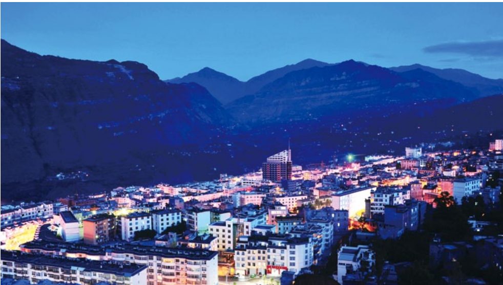
溪洛渡水电站工程库区云南省永善县，顺水出山、强势崛起，实现了由江边小县到水电新城的嬗变，成为全国县域经济基本竞争力提升速度最快的百强县之一。2012 年全县地区生产总值 400017 万元，比上年增长 16.4%
