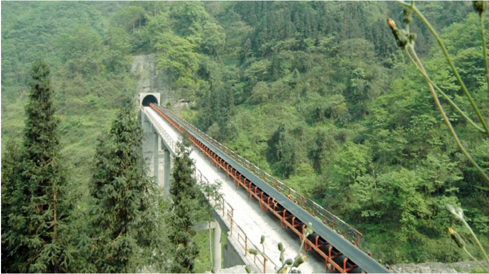
向家坝工程长距离骨料输送线
