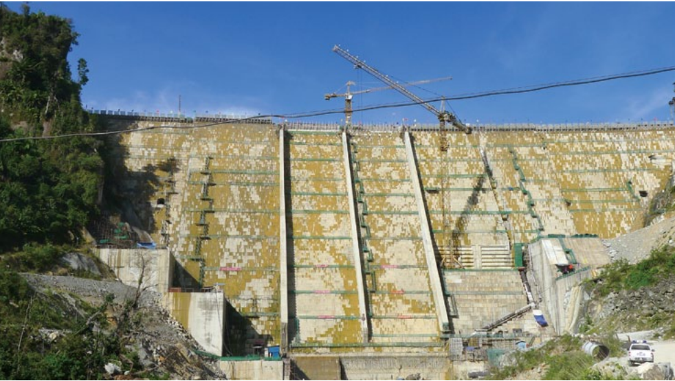
建设中的沐若水电站大坝
